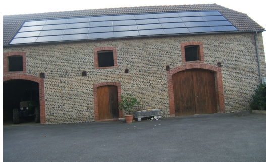
Bâtiments existants : grange, hangar
